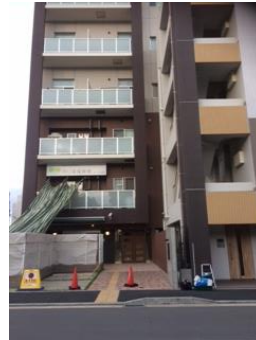
・乗降場所向かい側のマンション。2階に保育園あり。
