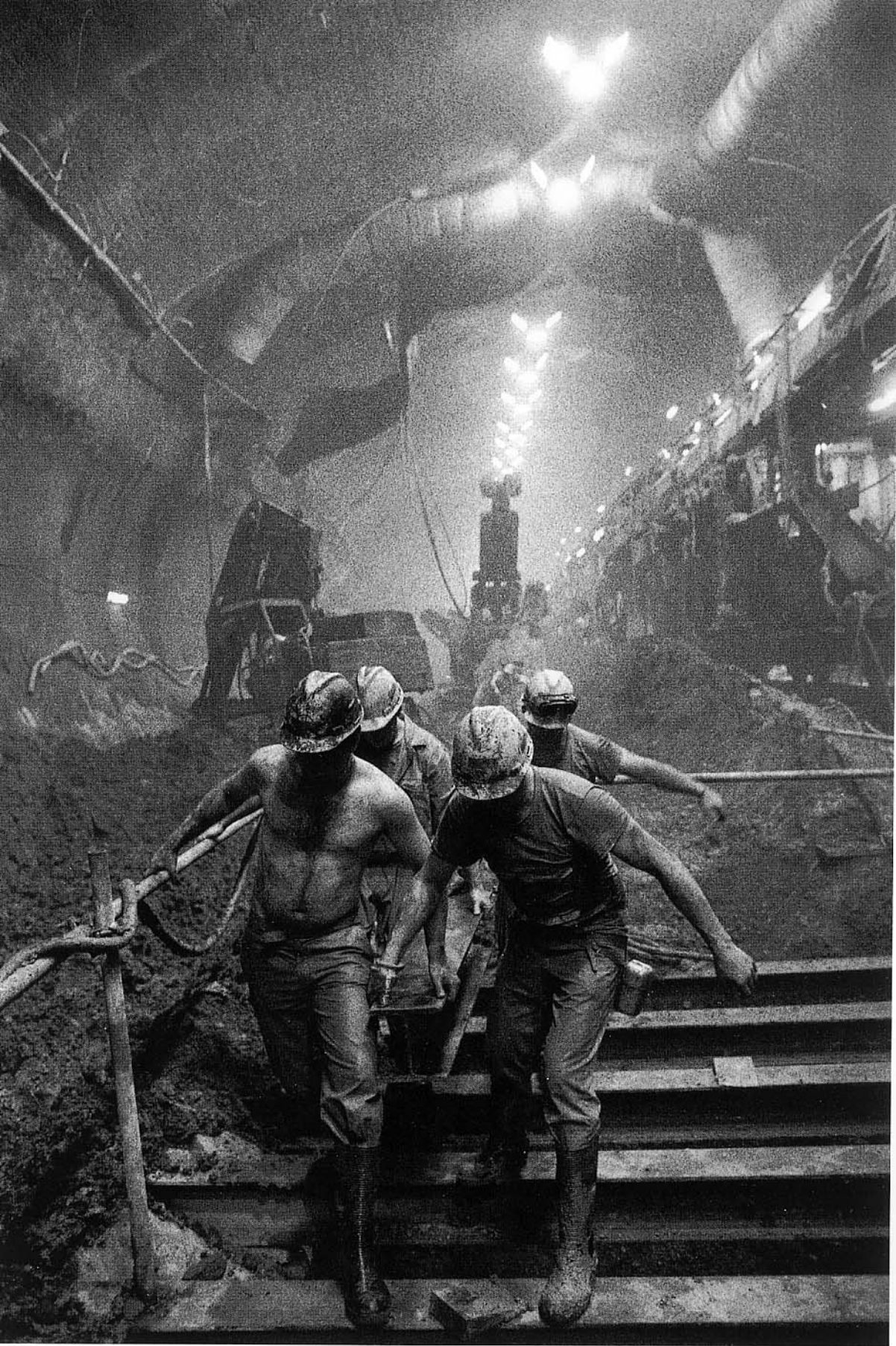
-219- 労働者たちがレールをとりつける。その上を機関車に牽引された2台の穿孔機のうちの1台がフランスへ渡っていくはずだ。 イギリス、フォークストーン、1990年 Workers place the rails on which one of the two train-driven cutting-head machines will cross to France. Folkstone, England, 1990
