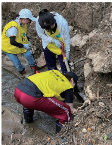
土管に詰まった土砂の除去作業(2025年8月)
