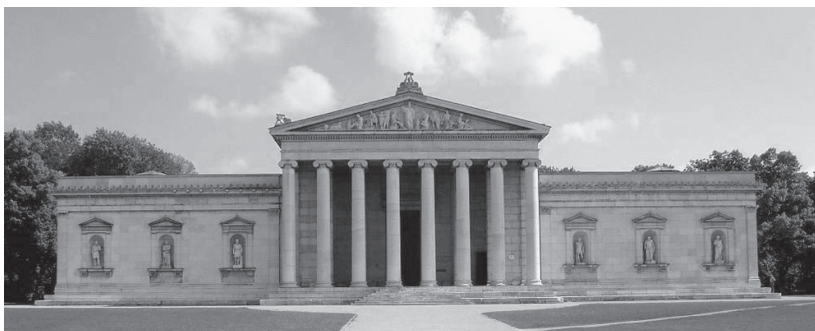
図3 クレンツェ設計 グリュプトテーク正面外観(再建後) ミュンヒェン、王の広場
